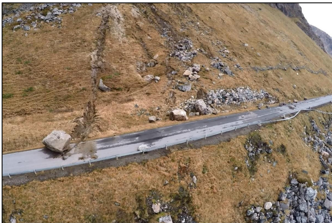
Figur 3. Steinskred 17.11.2014 der antatt totalt volum av steinmasser er 1200 m 3 som løstet fra nordre kløft. Legg merke til fanggerde sør for steinblokkene (t.h.).
