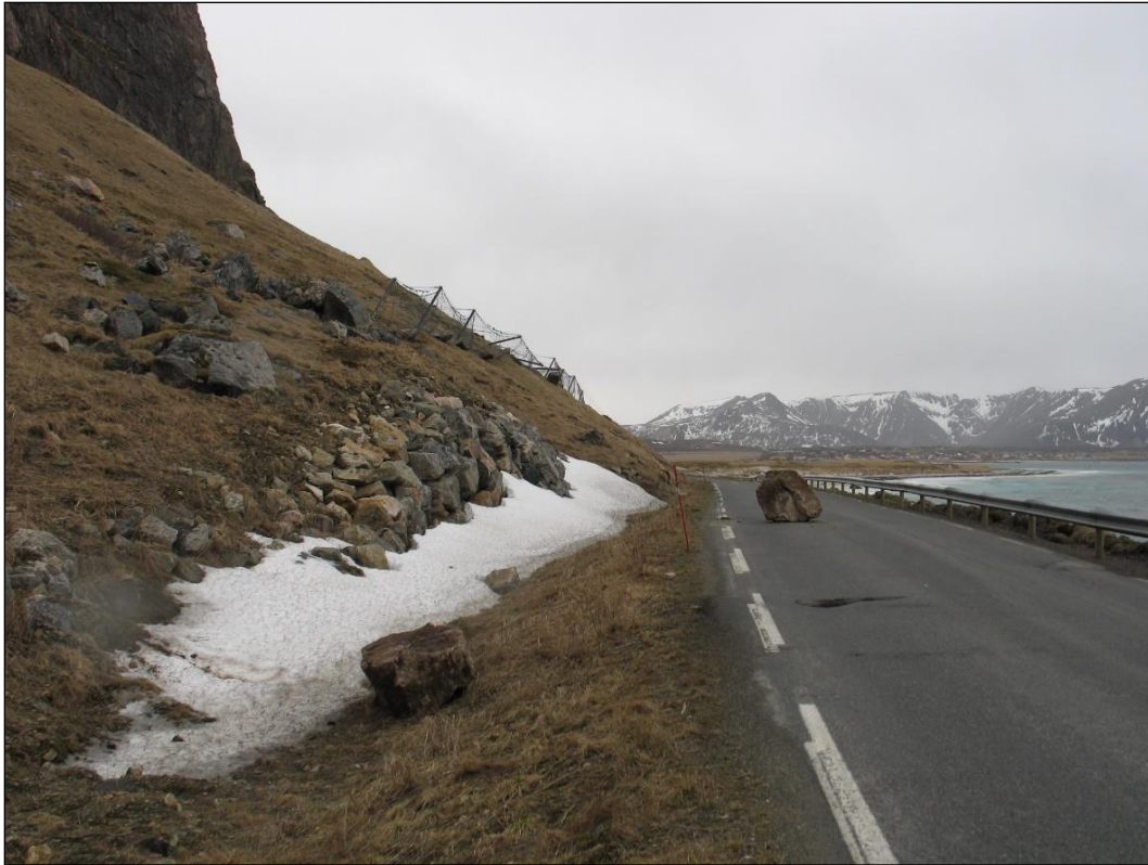
Figur 4. Steinsprang 25.04.2007 som løsnet fra søndre kløft og stoppet på veg nord for fanggjerde.
