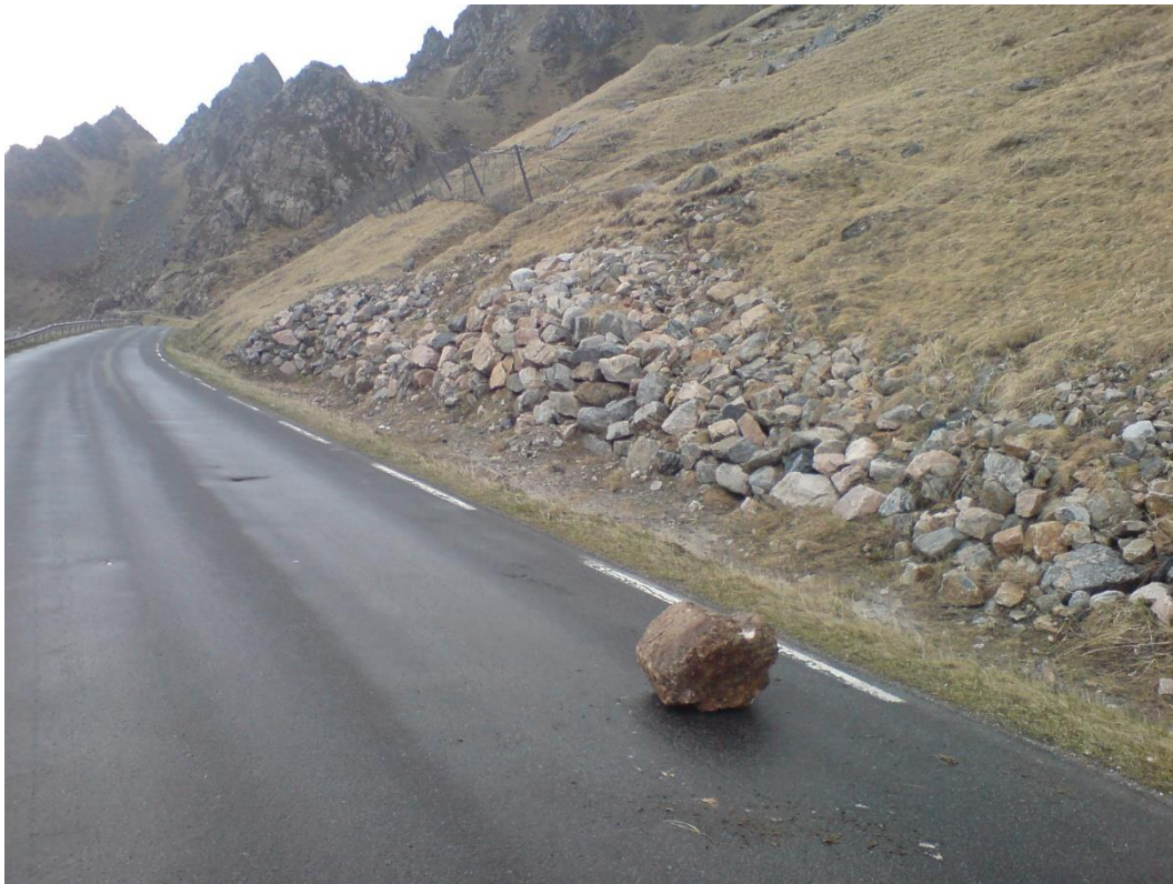
Figur 5. Steinsprang 11.05.2009 som stoppet på veg sør for fanggjerde.
