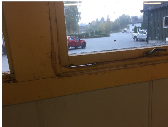
Figur 7: Vindu/vegg i eksisterende ettersedimenteringshall
