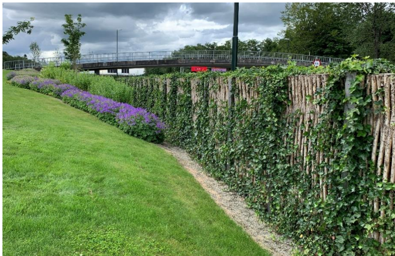
Støyskjerm med klatreplanter.
