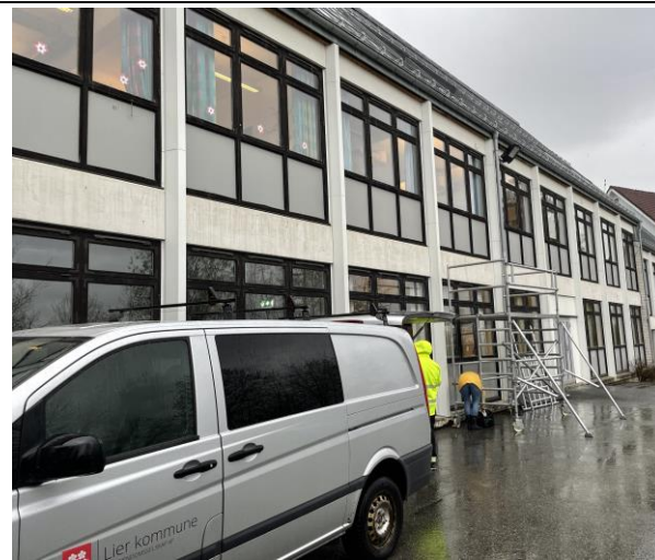
10: Bildet viser fasaden og rullestillas satt opp for prøvetaking. Det ble ikke tatt ut prøver på drager lengst opp mot tak.
