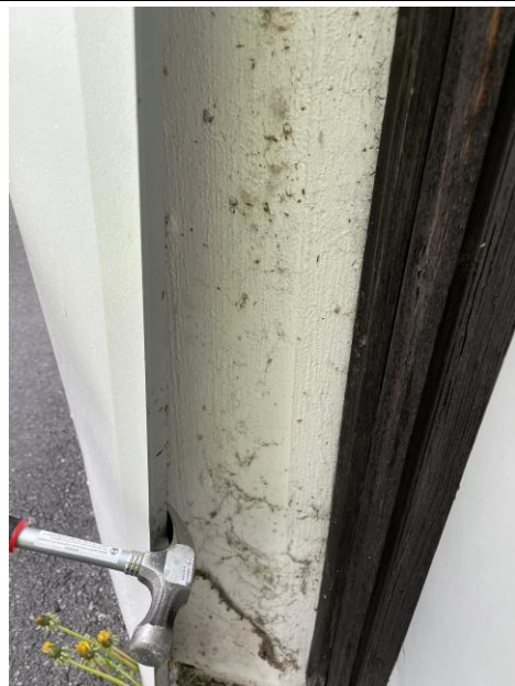
3: Betongen er også overflatebehandlet bak beslagene på søyler.
