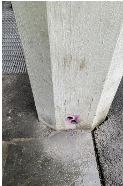
7: Bildet viser bunn av søyle ved inngangsparti. Ingen synlige skader.
