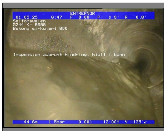
Foto: 5844_5244_8688_05022021_071814.JPG 7,2m, Inspeksjon avbrutt Hindring, hjull i bunn
