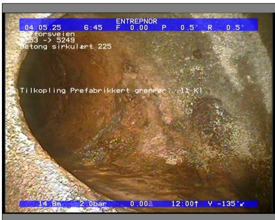
Foto: 5854_5249_5253_05022021_043856.JPG 14,82m, Tilkopling Prefabrikkert grenrør. 11 Kl.
