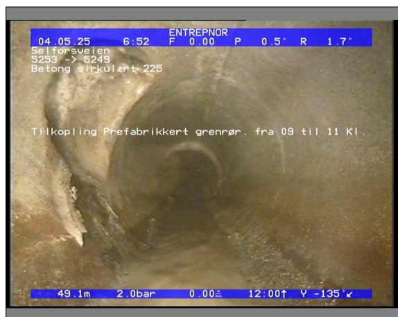
Foto: 5854_5249_5253_05022021_044550.JPG 49,16m, Tilkopling Prefabrikkert grennr. fra 09 til 11 Kl.
