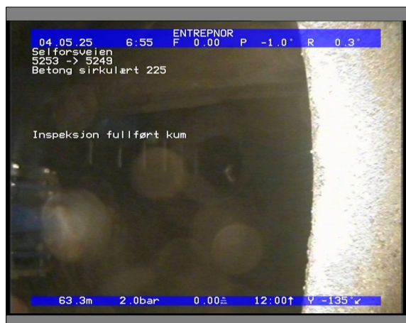
Foto: 5854_5249_5253_05022021_044846.JPG 63,35m, Inspeksjon fullført kum
