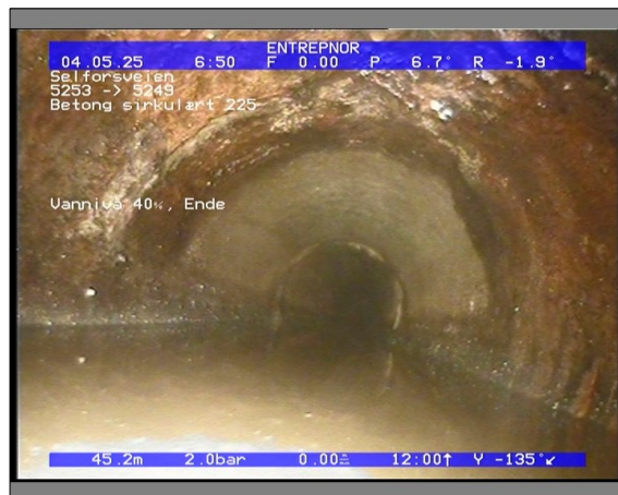
Foto: 5854_5249_5253_05022021_044402.JPG 45,28m, Vannivå 40%, Ende
