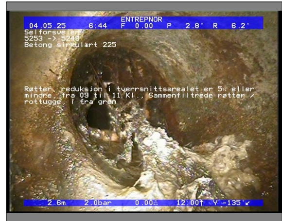
Foto: 5854_5249_5253_05022021_043741.JPG 2,68m, Røtter, reduksjon i tverrsnittsarealet er 5% eller mindre, fra 09 til 11 Kl., Sammenfiltrede røtter / rottugge, i fra gren
