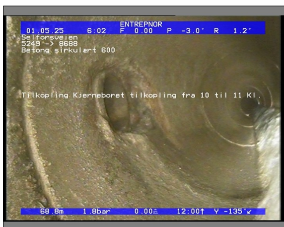
Foto: 5848_8688_5249_05022021_063345.JPG 68,89m, Tilkopling Kjerneboret tilkopling fra 10 til 11 Kl.
