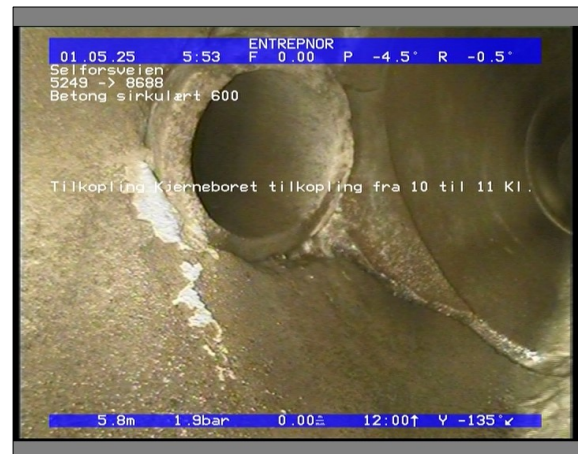
Foto: 5848_8688_5249_05022021_062432.JPG 5,81m, Tilkopling Kjerneboret tilkopling fra 10 til 11 Kl.
