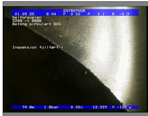
Foto: 5848_8688_5249_05022021_063530.JPG 74,83m, Inspeksjon fullført -
