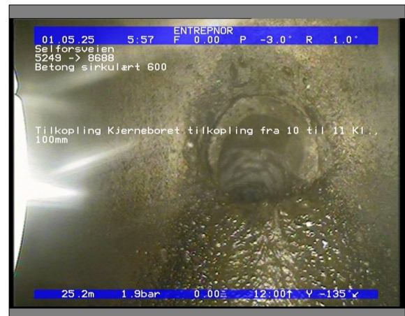
Foto: 5848_8688_5249_05022021_062813.JPG 25,23m, Tilkopling Kjerneboret tilkopling fra 10 til 11 Kl., 100mm
