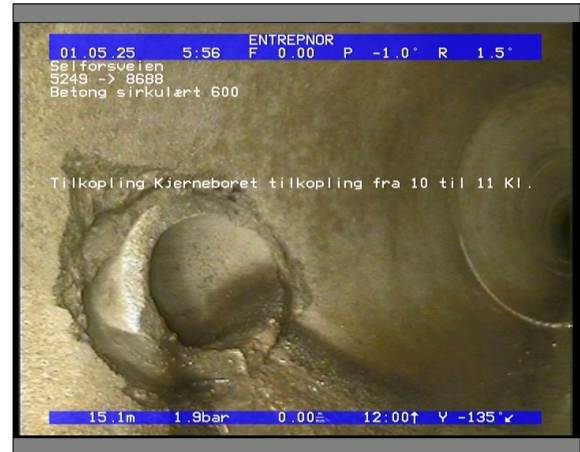
Foto: 5848_8688_5249_05022021_062651.JPG 15,17m, Tilkopling Kjerneboret tilkopling fra 10 til 11 Kl.
