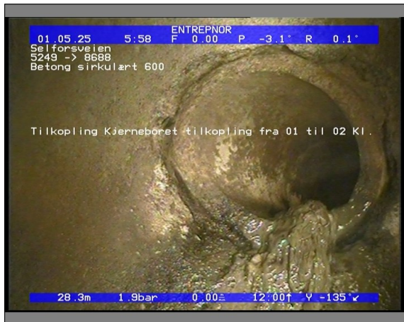
Foto: 5848_8688_5249_05022021_062854.JPG 28,36m, Tilkopling Kjerneboret tilkopling fra 01 til 02 Kl.
