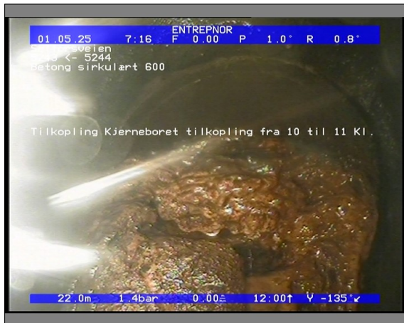
Foto: 5842_5243_5244_05022021_074742.JPG 22,02m, Tilkobling Kjerneboret tilkobling fra 10 til 11 KI.
