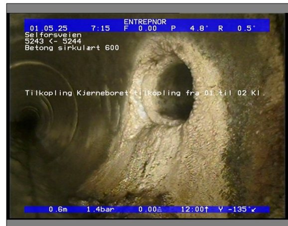
Foto: 5842_5243_5244_05022021_074554.JPG 0,65m, Tilkopling Kjerneboret tilkopling fra 01 til 02 Kl.
