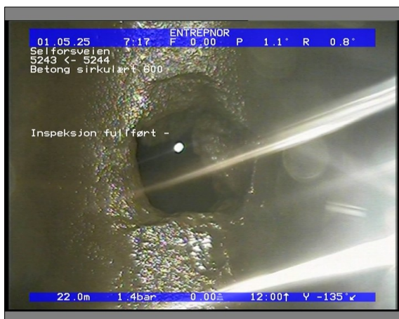
Foto: 5842_5243_5244_05022021_074829.JPG 22,02m, Inspeksjon fullført kum 5244
