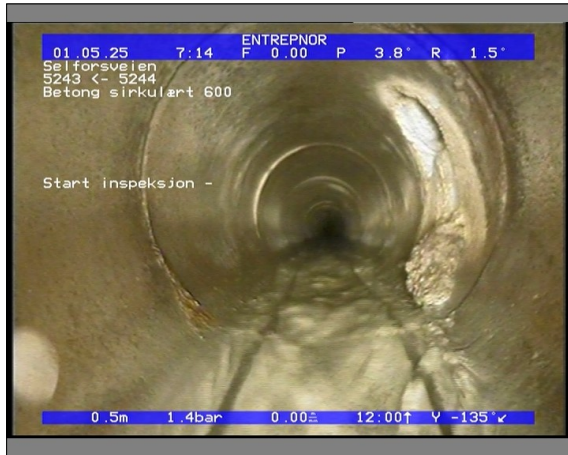
Foto: 5842_5243_5244_05022021_074513.JPG 0,5m, Start inspeksjon -
