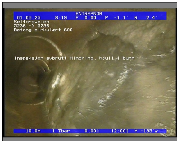
Foto: 5834_5236_5238_05022021_085044.JPG 10,06m, Inspeksjon avbrutt Hindring, hjull i bunn
