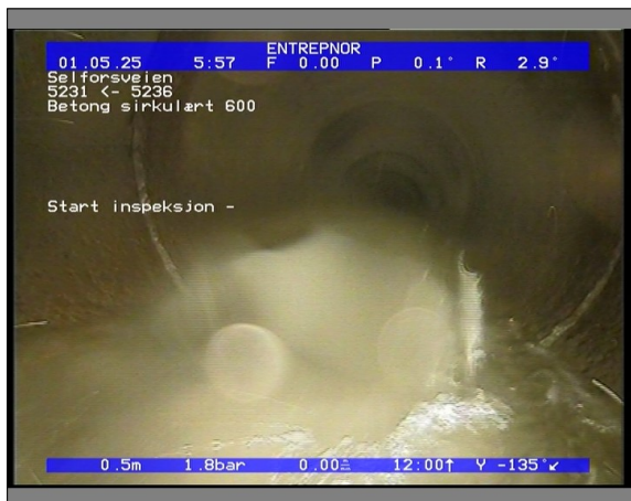
Foto: 5828_5231_5236_05022021_061943.JPG 0,5m, Start inspeksjon -
