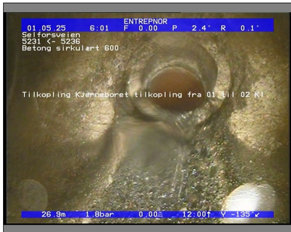
Foto: 5828_5231_5236_05022021_062401.JPG 26,93m, Tilkopling Kjerneboret tilkopling fra 01 til 02 Kl.
