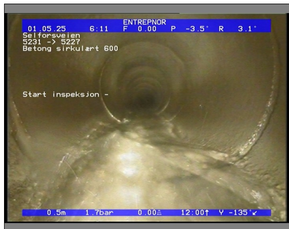
Foto: 5822_5227_5231_05022021_063332.JPG 0,5m, Start inspeksjon -
