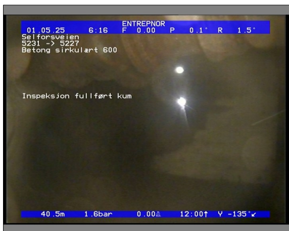
Foto: 5822_5227_5231_05022021_063815.JPG 40,58m, Inspeksjon fullført kum
