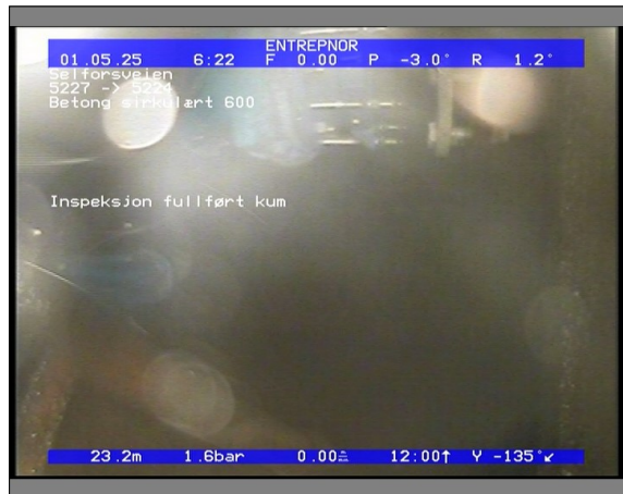
Foto: 5820_5224_5227_05022021_064442.JPG 23,27m, Inspeksjon fullført kum
