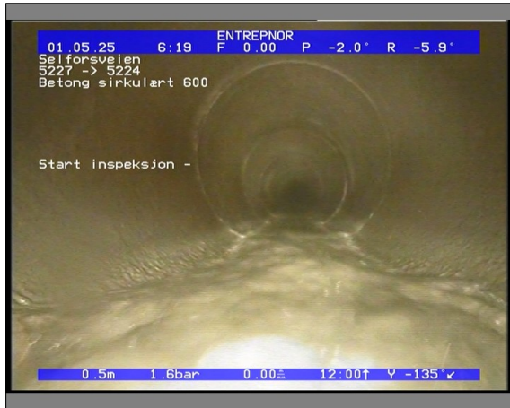
Foto: 5820_5224_5227_05022021_064116.JPG 0,5m, Start inspeksjon -
