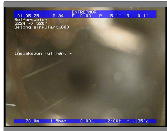
Foto: 5814_5207_5224_05022021_065644.JPG 70,02m, Inspeksjon fullført -
