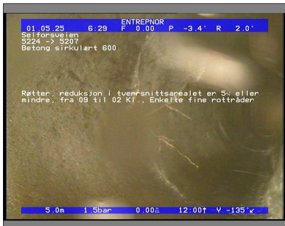
Foto: 5814_5207_5224_05022021_065113.JPG 5,02m, Røtter, reduksjon i tverrsnittsarealet er 5% eller mindre, fra 09 til 02 Kl., Enkelte fine rottråder
