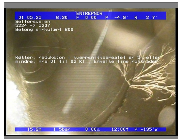
Foto: 5814_5207_5224_05022021_065238.JPG 15,94m, Røtter, reduksjon i tverrsnittsarealet er 5% eller mindre, fra 01 til 02 Kl., Enkelte fine rottråder
