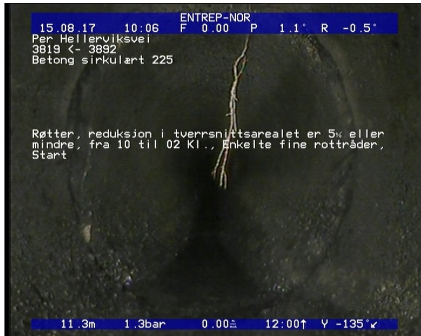
Foto: 101_101_458_A.JPG 11,36m, Røtter, reduksjon i tverrsnittsarealet er 5% eller mindre, fra 10 til 02 Kl., Enkelte fine rottråder, Start
