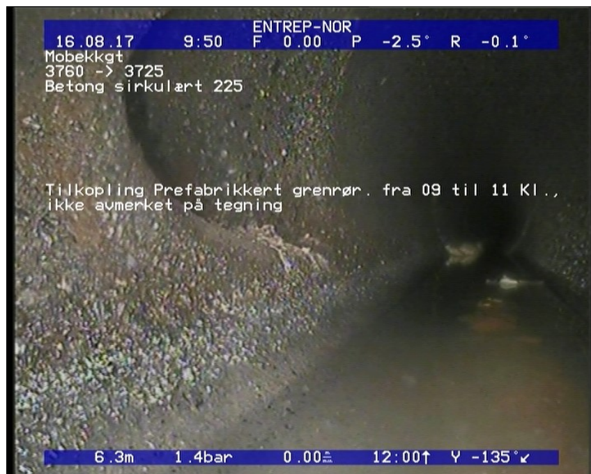
Foto: 2_2_522_A.JPG 6,34m, Tilkopling Prefabrikkert grennrør. fra 09 til 11 Kl., ikke avmerket på tegning
