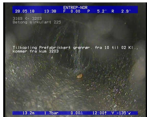
Foto: Tilkopling Prefabrikkert grennrør. fra 10 til 02 Kl., kommer fra kum 3203_13414213,26_TK.JPG 13,26m, Tilkopling Prefabrikkert grennrør. fra 10 til 02 Kl., kommer fra kum 3203
