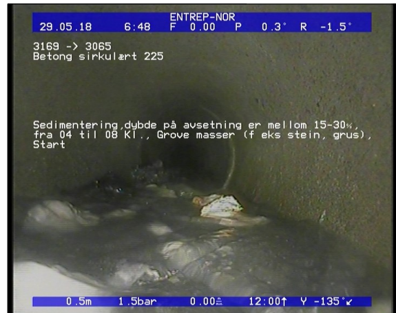
Foto: Sedimentering,dybde på avsetning er mellom 15-30, fra 04 til 08 Kl., Grove masser (f eks stein.JPG 0,5m, Sedimentering,dybde på avsetning er mellom 15-30%, fra 04 til 08 Kl., Grove masser (f eks stein, grus), Start
