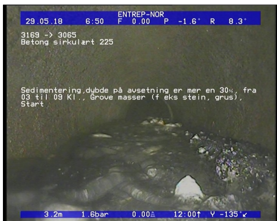
Foto: Sedimentering,dybde på avsetning er mer en 30, fra 03 til 09 Kl., Grove masser (f eks stein, g.JPG 3,22m, Sedimentering,dybde på avsetning er mer en 30%, fra 03 til 09 Kl., Grove masser (f eks stein, grus), Start
