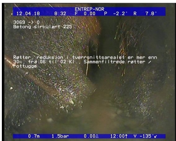
Foto: Røtter, reduksjon i tverrsnittsarealet er mer enn 30%, fra 06 til 02 Kl., Sammenfildrede røtter.JPG 0,76m, Røtter, reduksjon i tverrsnittsarealet er mer enn 30%, fra 06 til 02 Kl., Sammenfildrede røtter / rottugge
