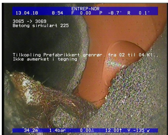
Foto: Tilkobling Prefabrikkert grennrør, fra 02 til 04 Kl., Ikke avmerket i tegning_08581034,22_TK.JPG 34,22m, Tilkobling Prefabrikkert grennrør, fra 02 til 04 Kl., Ikke avmerket i tegning
