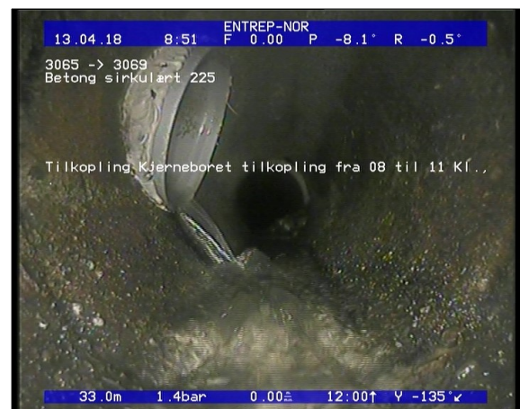
Foto: Tilkopling Kjerneboret tilkopling fra 08 til 11 Kl., _08553133,01_TK.JPG 33,01m, Tilkopling Kjerneboret tilkopling fra 08 til 11 Kl., .
