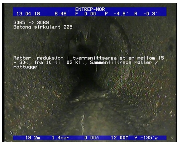
Foto: Røtter, reduksjon i tverrsnittsarealet er mellom 15 - 30, fra 10 til 02 Kl., Sammenfildrede rø.JPG 18,26m, Røtter, reduksjon i tverrsnittsarealet er mellom 15 - 30%, fra 10 til 02 Kl., Sammenfildrede røtter / rottugge
