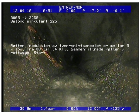
Foto: Røtter, reduksjon av tverrsnittetsarealet er mellom 5 - 15%, fra 08 til 04 Kl., Sammenfiltrede rø. JPG 30,91m, Røtter, reduksjon av tverrsnittetsarealet er mellom 5 - 15%, fra 08 til 04 Kl., Sammenfiltrede røtter / rottugge, Start
