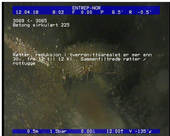
Foto: Røtter, reduksjon i tverrsnittsarealet er mer enn 30, fra 12 til 12 Kl., Sammenfiltrede røtter.JPG 54,81m, Røtter, reduksjon i tverrsnittsarealet er mer enn 30%, fra 12 til 12 Kl., Sammenfiltrede røtter / rottugge
