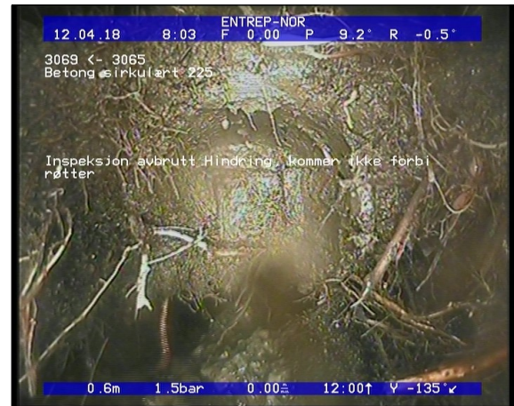
Foto: Inspeksjon avbrutt Hindring, kommer ikke forbi røtter_0807280,6_IA.JPG 54,71m, Inspeksjon avbrutt Hindring, kommer ikke forbi røtter
