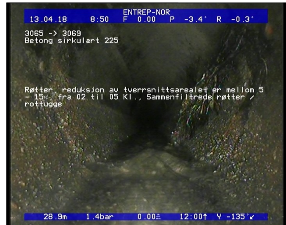
Foto: Røtter, reduksjon av tverrsnittetsarealet er mellom 5 - 15%, fra 02 til 05 Kl., Sammenfiltrede rø. JPG 28,9m, Røtter, reduksjon av tverrsnittetsarealet er mellom 5 - 15%, fra 02 til 05 Kl., Sammenfiltrede røtter / rottugge
