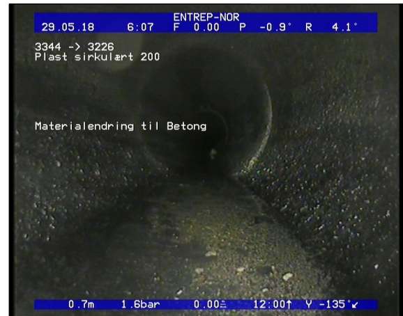
Foto: Materialendring til Betong_0611020,7_ME.JPG 0,7m, Materialendring til Betong
