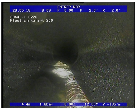
Foto: Hindring, reduksjon i tverrsnittsareal er mellom 5-15, fra 05 til 07 Kl., Andre, jernstang_0612.JPG 4,45m, Hindring, reduksjon i tverrsnittsareal er mellom 5-15%, fra 05 til 07 Kl., Andre, jernstang
