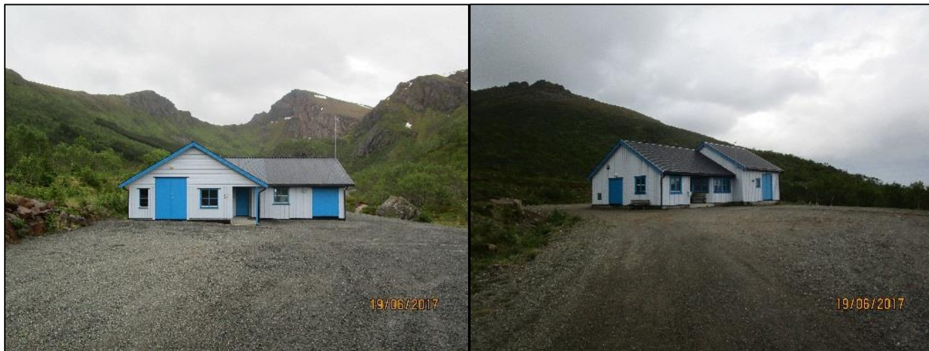
Figur 6.2.1.1: Stavdalsvannet vannbehandlingsanlegg. Figur 6.2.1.2: Trettendalsvannet VBA.
