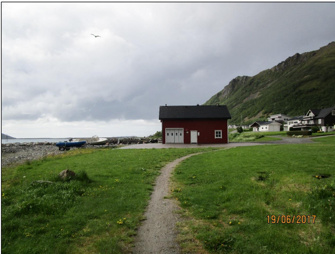
Figur 7.1.1.1: Silanlegg på Myre.
