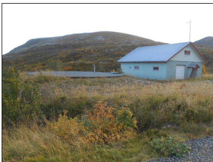
Figur 6.2.2.3: Ytre Langenes vannbehandlingsanlegg og høydebasseng.
