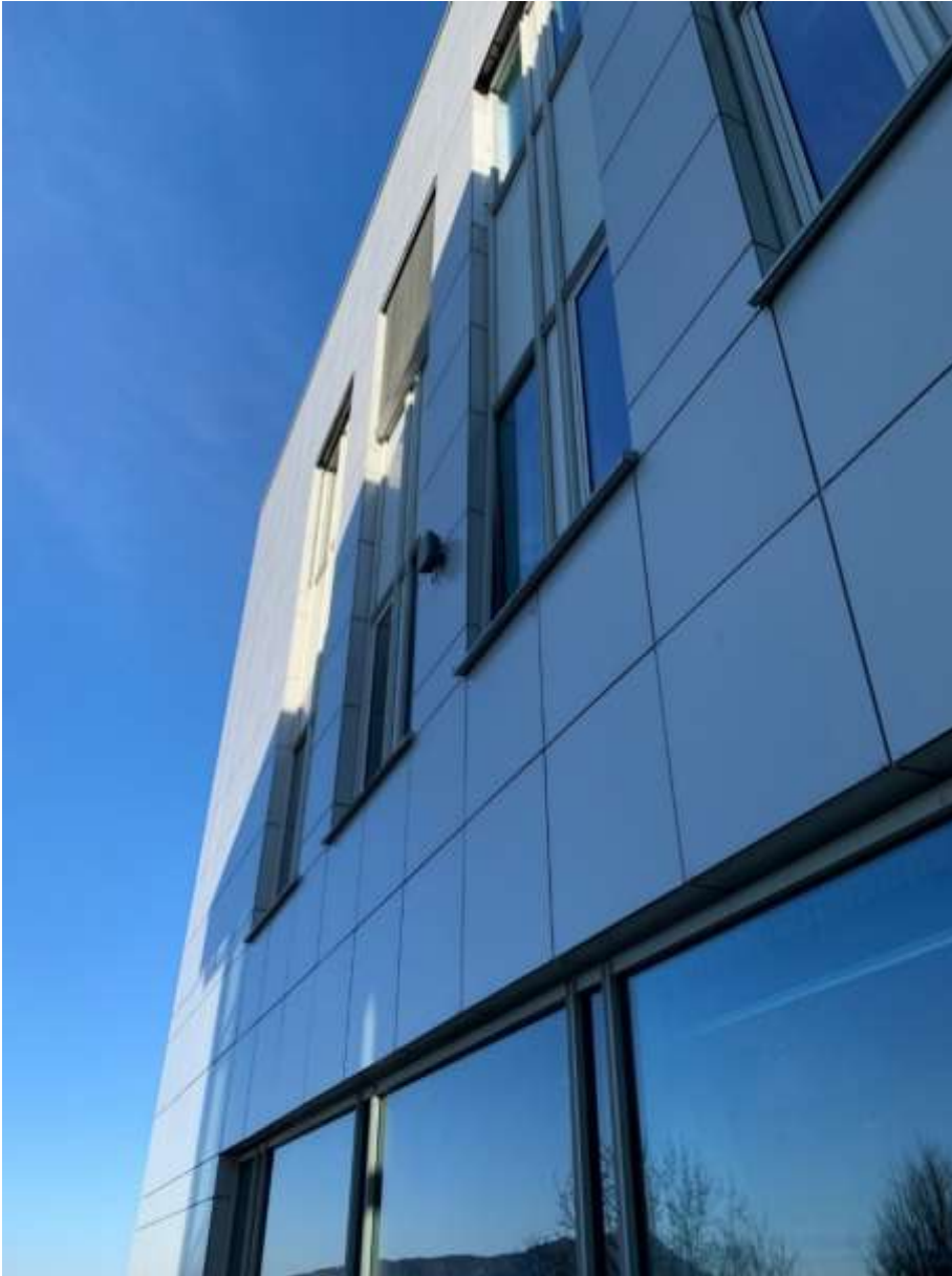
Foto 7: Det er en rekke vinduer i fasaden. Det må medtas tilpasninger omkring disse. Endelig utseende skal være mest mulig likt eksisterende.
