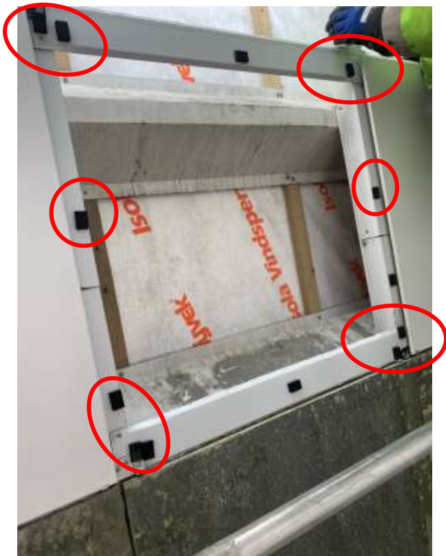
Foto 4: Her vises «putene». Det skal monteres puter i alle hjørner og også noen på de vertikale profilene.
