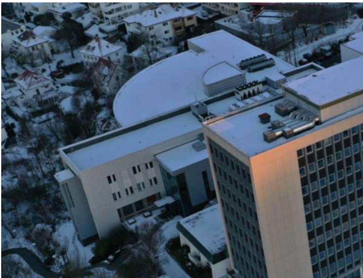
Foto 2: Oversikt over deler av fasaden på Servicebygget.
