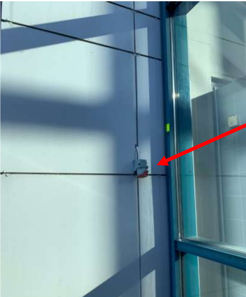
Foto 6: Her sees et støpsel. Det må medtas en del ekstra «plunder og heft» knyttet til slike elementer på fasaden.
