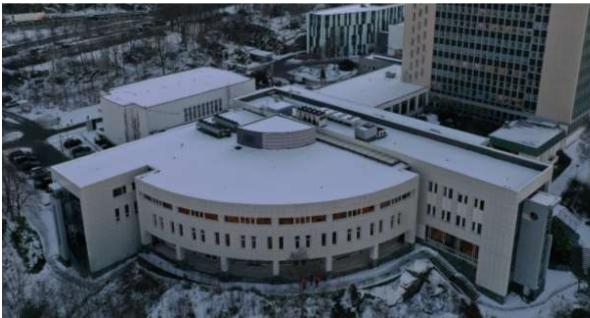
Foto 1: Oversiktsbilde av fasaden på Servicebygget.
