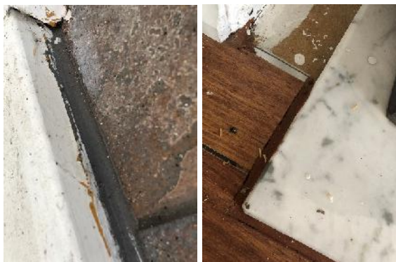
Bilde 25: Myk fugemasse med ftalater (nr. 199, 201, 209)
