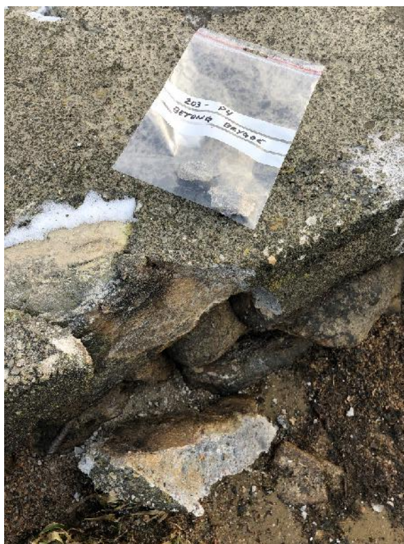
Bilde 11: Prøve 203 – P4, betong brygge
