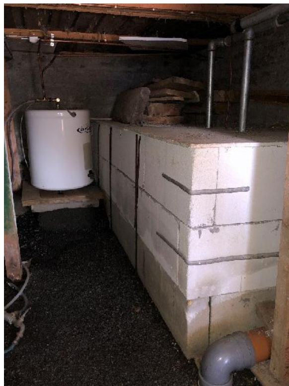
Bilde 10: VVB og oljetank, råkjeller (nr. 195)
