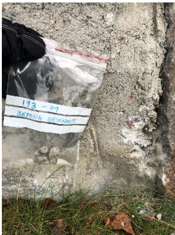
Bilde 3: Prøve 193 – P1, betong grunnmur
