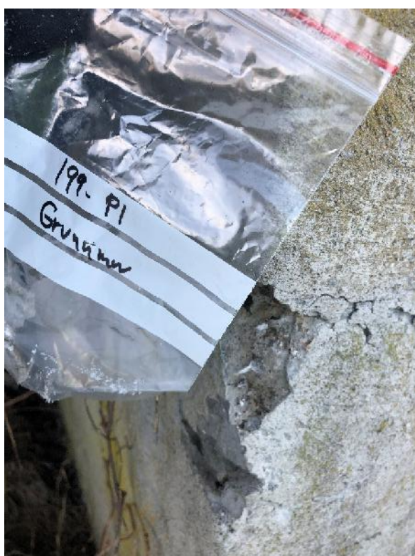
Bilde 5: Prøve 199 – P1, grunnmur
