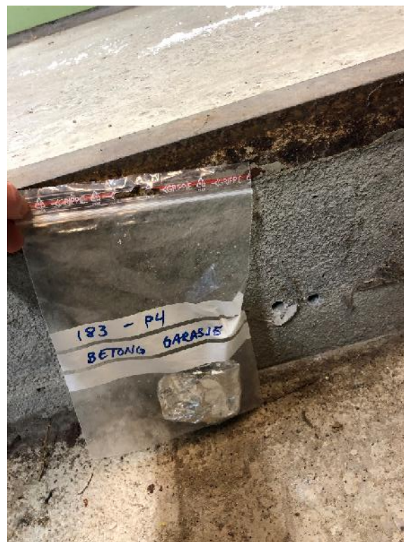
Bilde 8: Prøve 183 – P4, betong garasje
