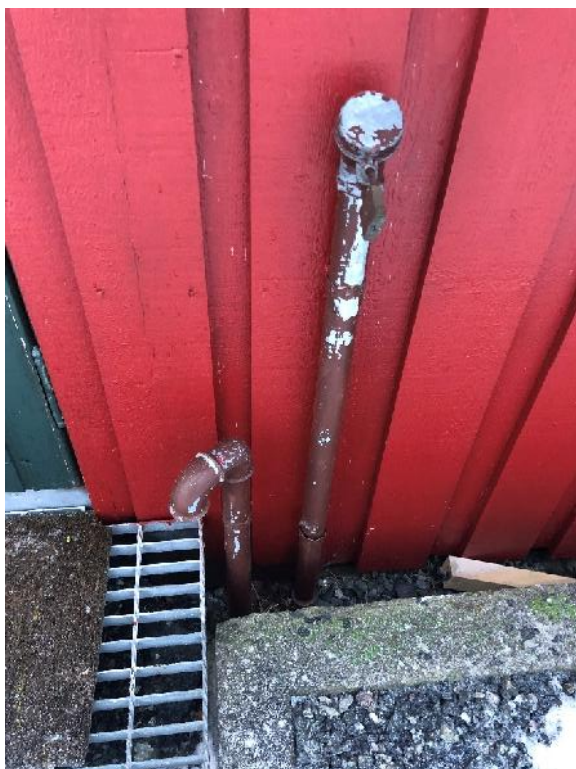
Bilde 11: Nedgravd oljetank under garasje (nr. 211)
