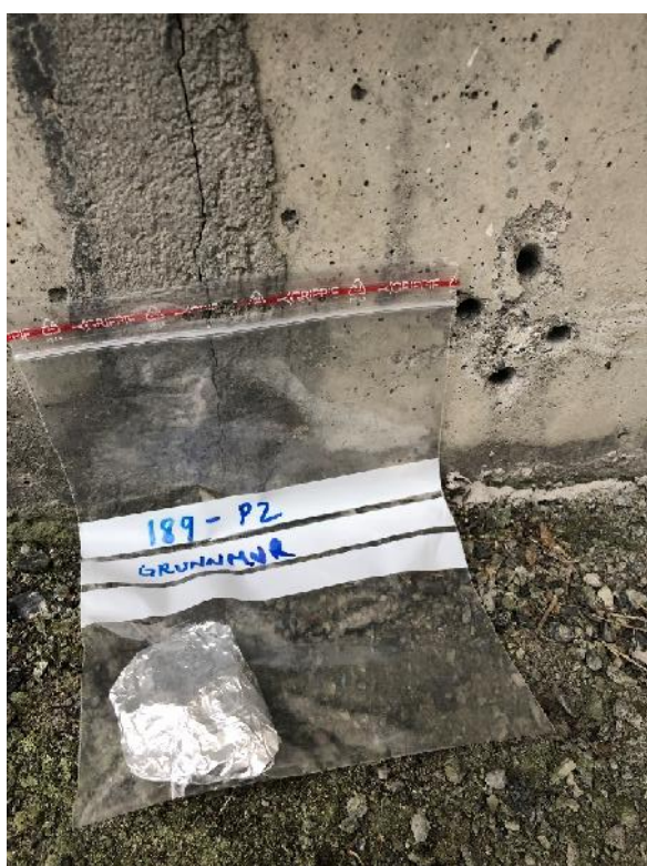
Bilde 11: Prøve 189 – P2, grunnmur
