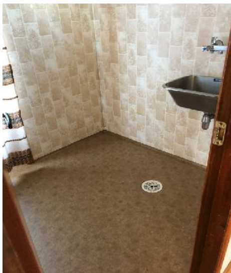
Bilde 17: Vinylbelegg med klorparafiner (nr. 195)
