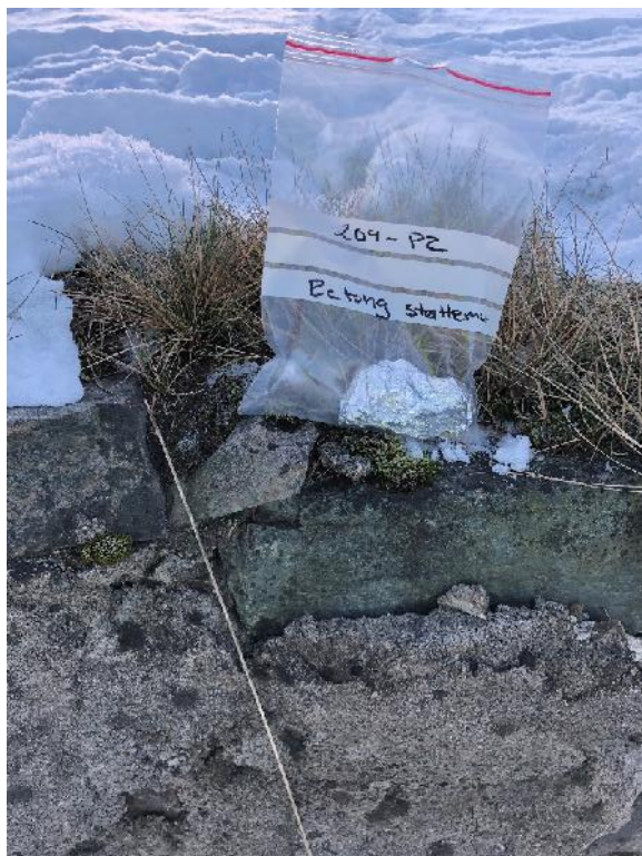
Bilde 19: Prøve 209 – P2, betong støttemur
