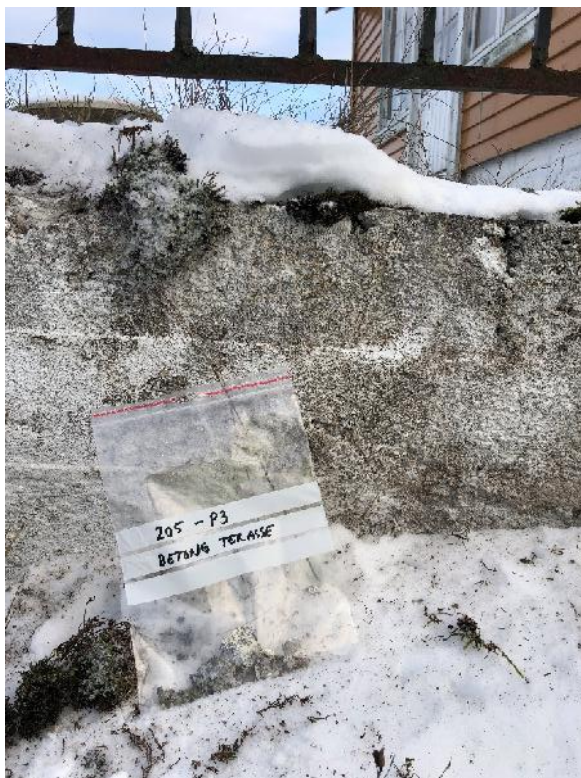
Bilde 15: Prøve 205 – P3, betong terrasse
