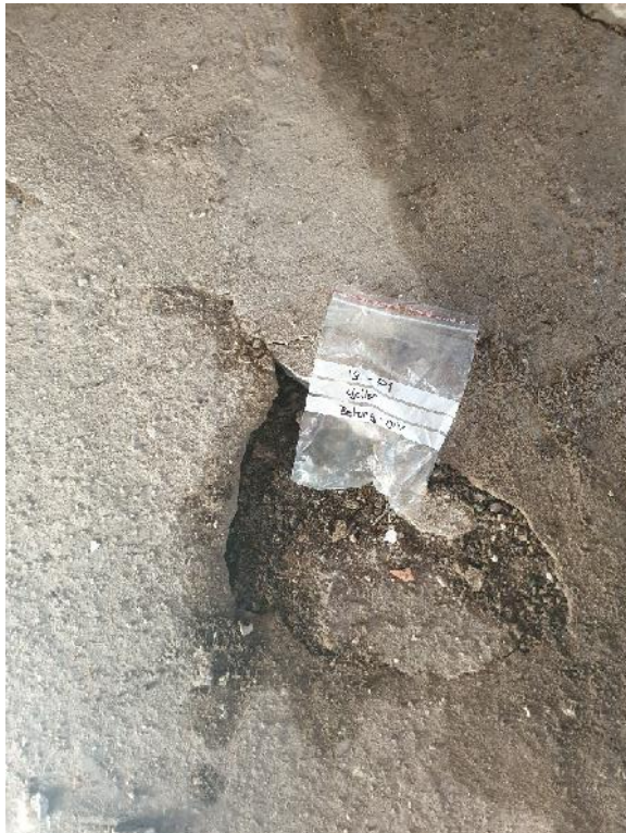
Bilde 1: Prøve 181 – P1, betonggulv kjeller
