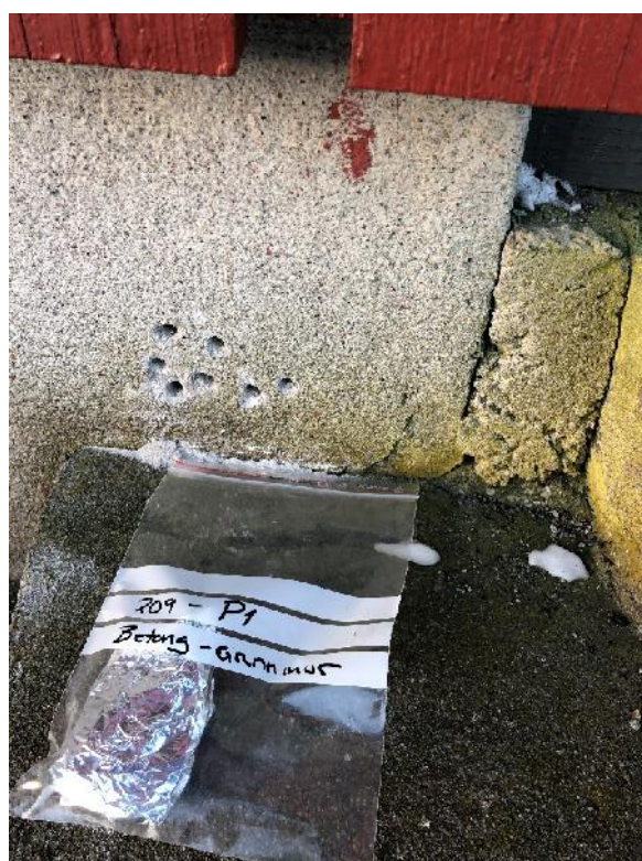
Bilde 18: Prøve 209 – P1, betong grunnmur
