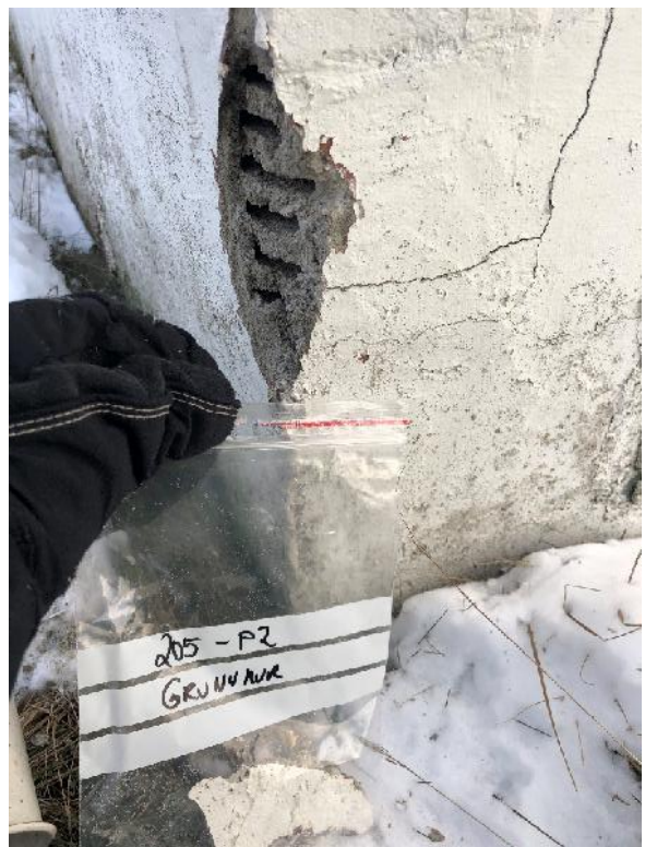
Bilde 14: Prøve 205 – P2, grunnmur
