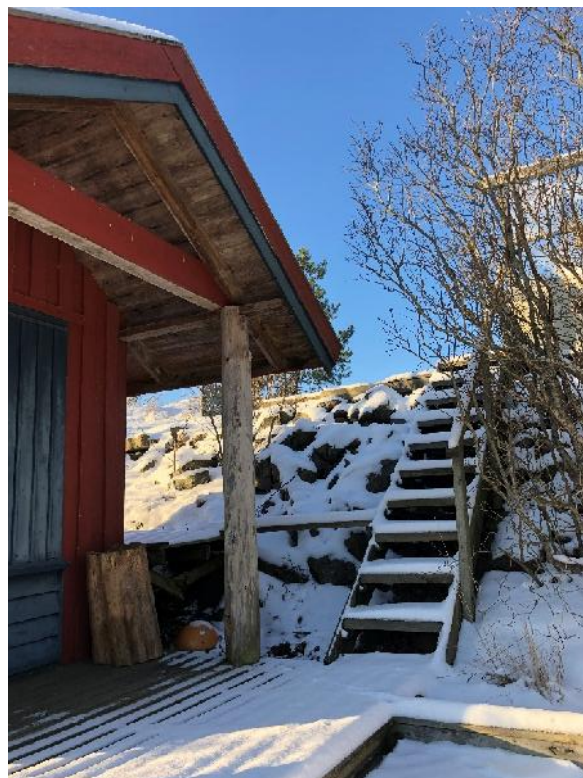
Bilde 14: Eksempel på terrasser med CCA-impregnert treverk
