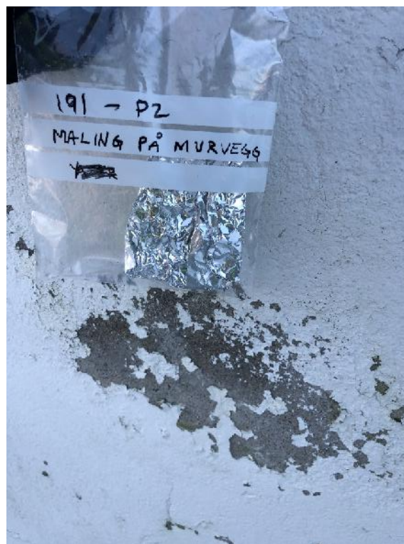
Bilde 2: Prøve 191 – P2, maling på mur yttevegg
