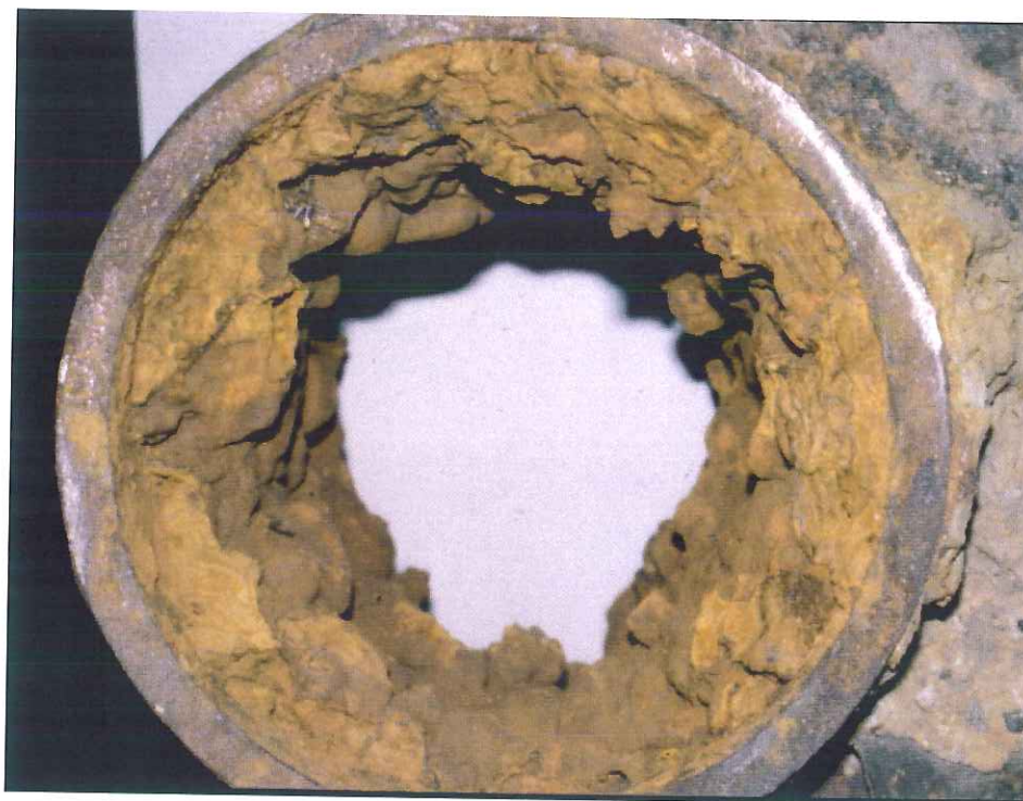
En gjengrodd støpejernsledning eller stålledning
