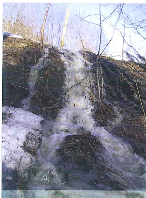
Figur 2 Lekkasje på hovedledning - Prestegårdsjordet våren 2004
