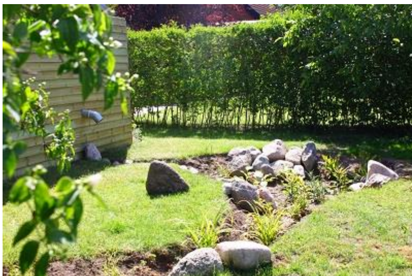
Figur 7: Eksempel på lokal håndtering av overvann i grønne forsenkninger
