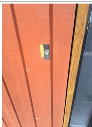
Eksempel på ringeklokke innfelt i fasaden
