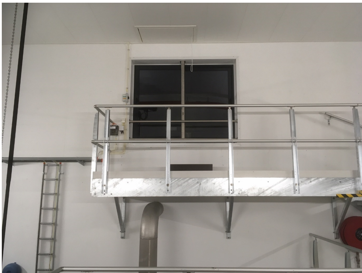
Adkomst for inspeksjon av vannspeil
