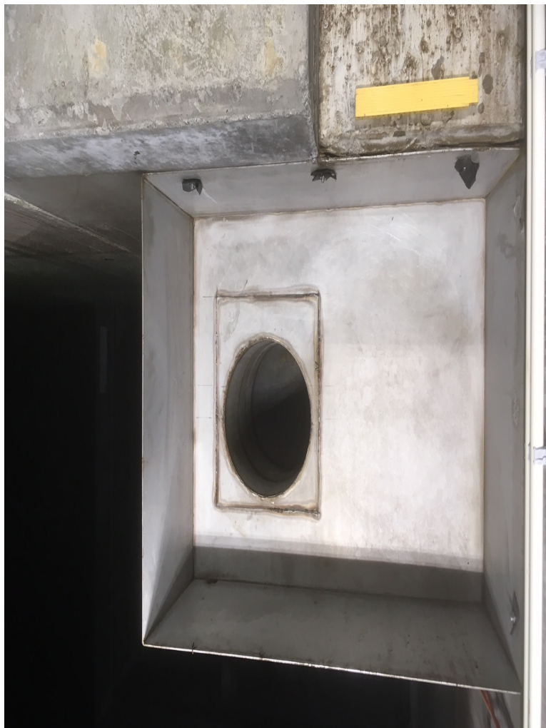
Overløpskasse og utsparring i betong mellom bassengene
