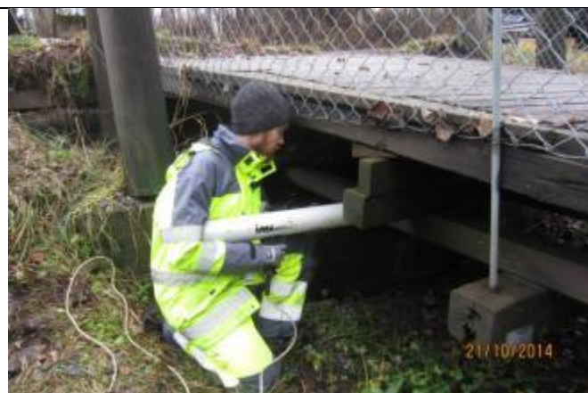
Bilde 6.2 Prøvetakning med bruk av råte drill ved akse 34-35
