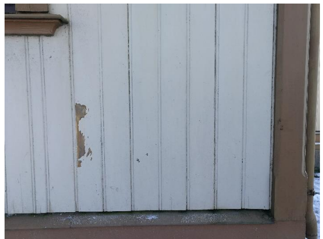
Parti med maling uten heft på nordvegg til dåpsrom.
