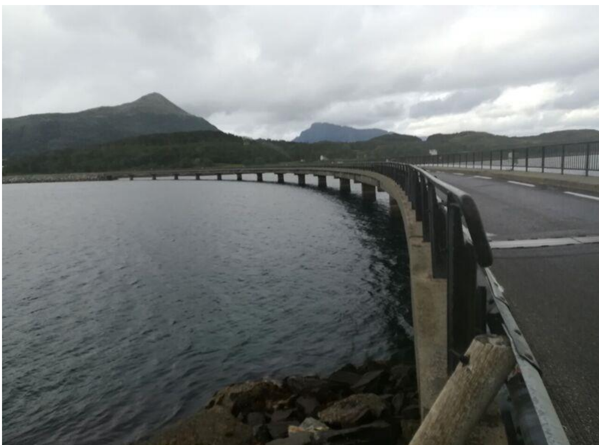
Figur 3 Engeløya lavbru, bildet tatt fra sørsiden (Bogen)
