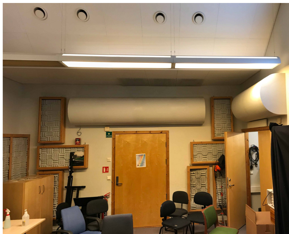
Studio - eks. bøyde gipsplater og eks. veggabsorbenter demonteres Eks. to-fløyet dør inntil lagerrom erstattes med skyvedør
