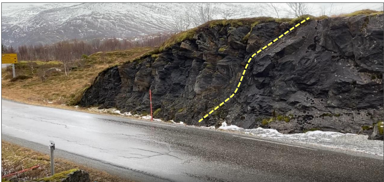
Figur 3: Østre del av BS1 sett mot øst. Fv. 17 i venstre bildekant. Svakhetssone antyda i stipla gult.
