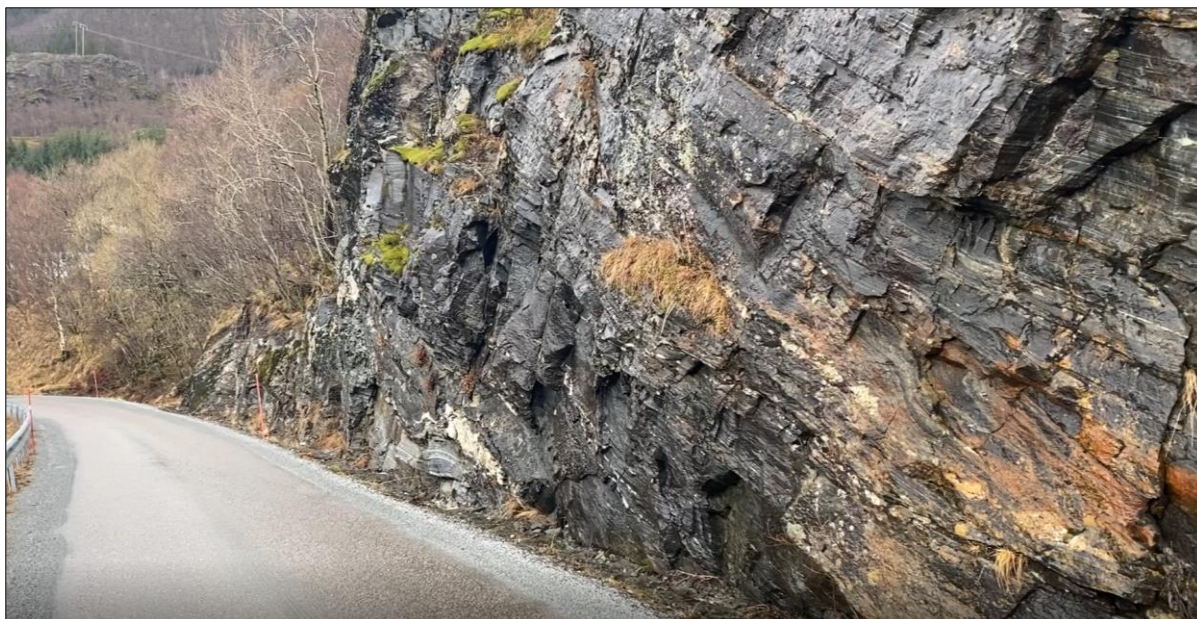
Figur 5: Høyeste og bratteste del av BS2 sett mot nord.
