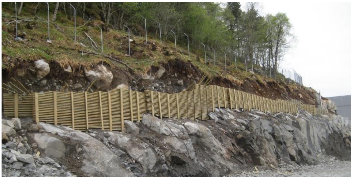
Figur 8- Illustrasjonsbilde av sognemur over bergskjæring for å holde løsmasser og stoppe nedfall av steiner.
