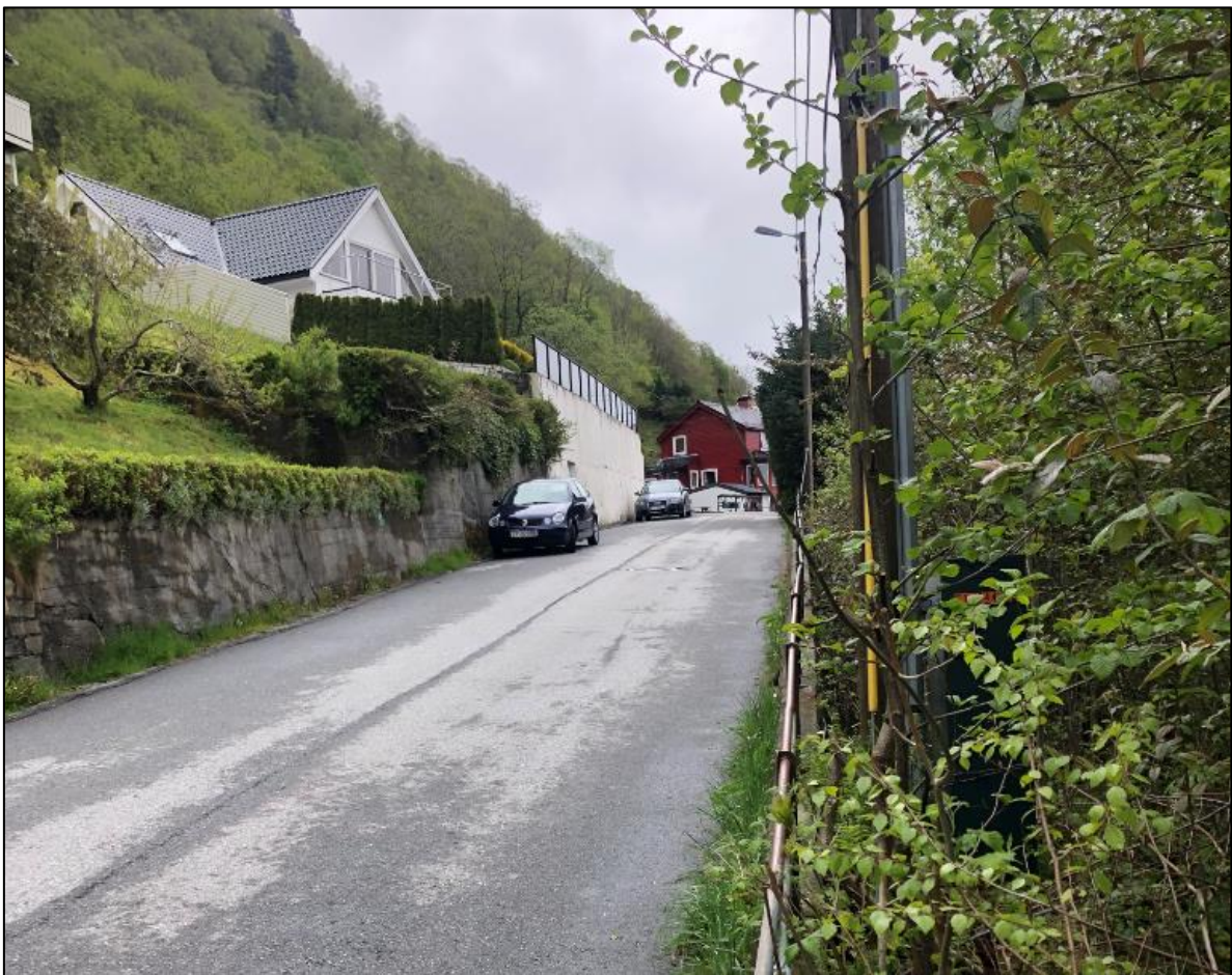
Figur 5-2: Bildet er tatt mot sør og viser veien (Kolstien) og skogsområdet like vest for muren på høyresiden av veien.
