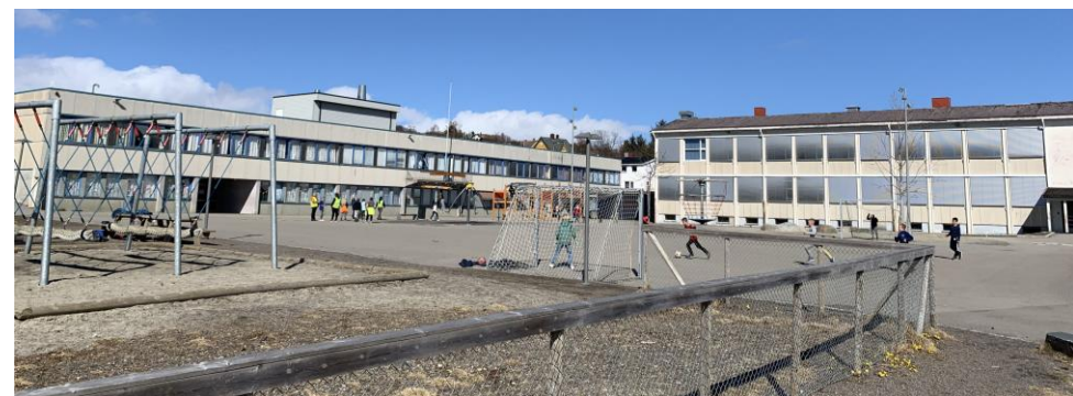
Bildet viser Sortland barneskoles to bygg, fra sydøst, det eldste til høyre
