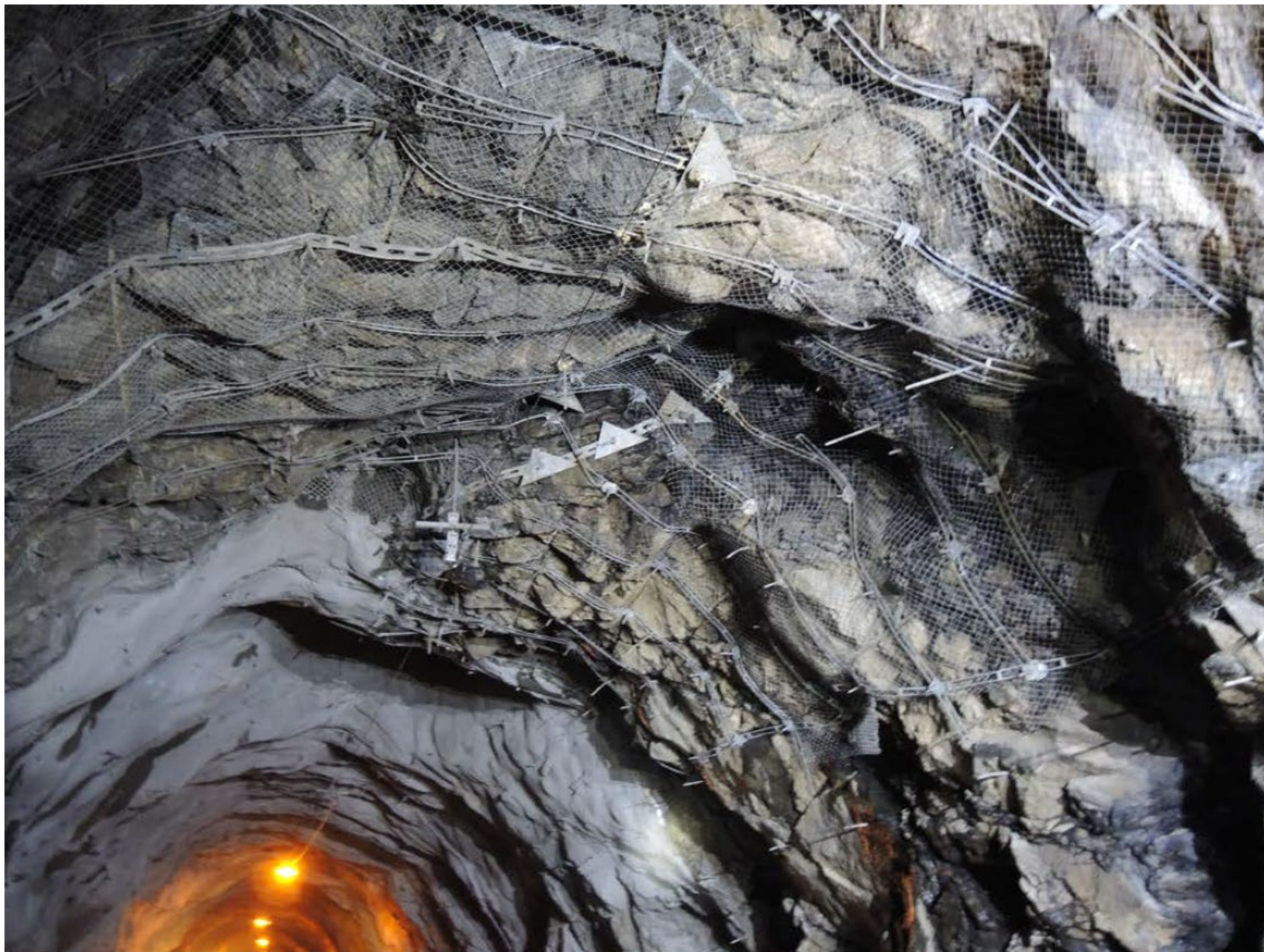
Figur 8. Foto av område under PE-skum ved pel 1027-1050. Fotoet er tatt fra notatet «Sikringsvurdering av svakhetssone med antatt svelleleire mellom ~pel 1027-1050. Per Nyberg, Statens vegvesen 2014-10-10 [7]. Fotoet ble tatt før sikringsarbeidene påbegynte, og man antar at det er svelleleire i dette området. Fjellkvaliteten her er generelt dårlig.
