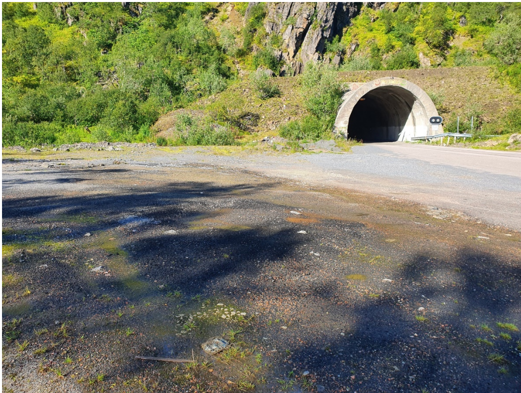
Figur 2. Flatt terreng med tynt løsmasser lag over bart fjell ved sørøstlig portal av tunnelen.
