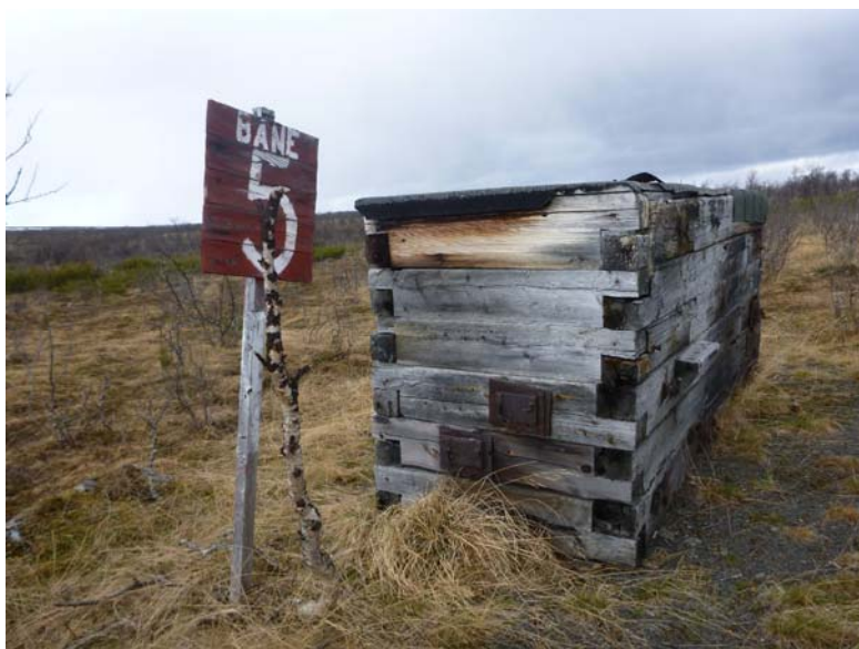
Figur 26 Standplass med stillinger opparbeidet av kreosotsviller.
