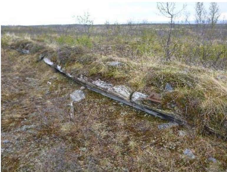
Figur 28 Målvoll ved bane 5. Målvollene er opparbeidet med kreosotsviller og stedlige masser av sand og vegetasjon.
