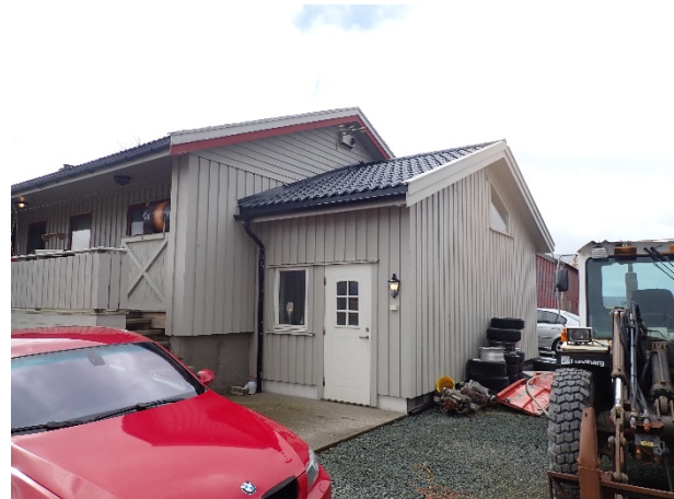
Figur 6 Fasade mot nord, med tilbygg.
