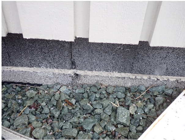
Figur 16 Grunnmur av leca i tilbygg.
