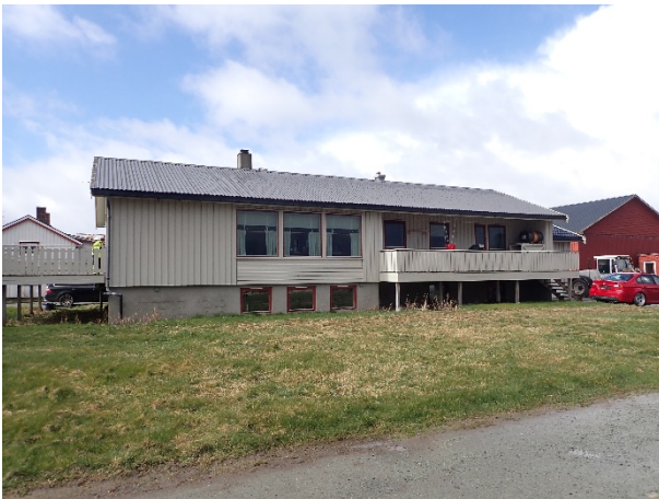
Figur 5 Fasade mot øst.
