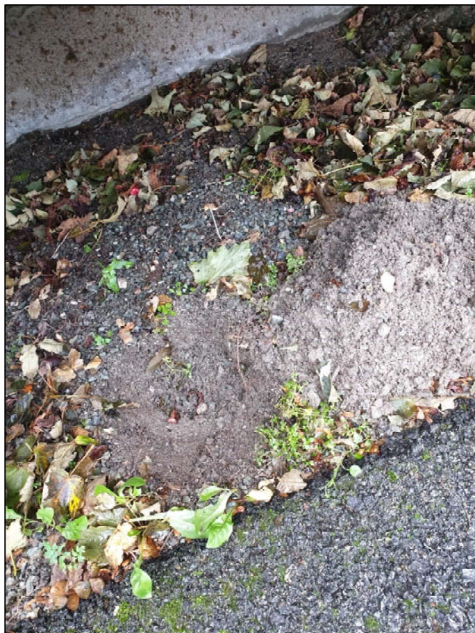
Figur 8: Bilde av masser inntil inngangsparti. Foto Multiconsult.
