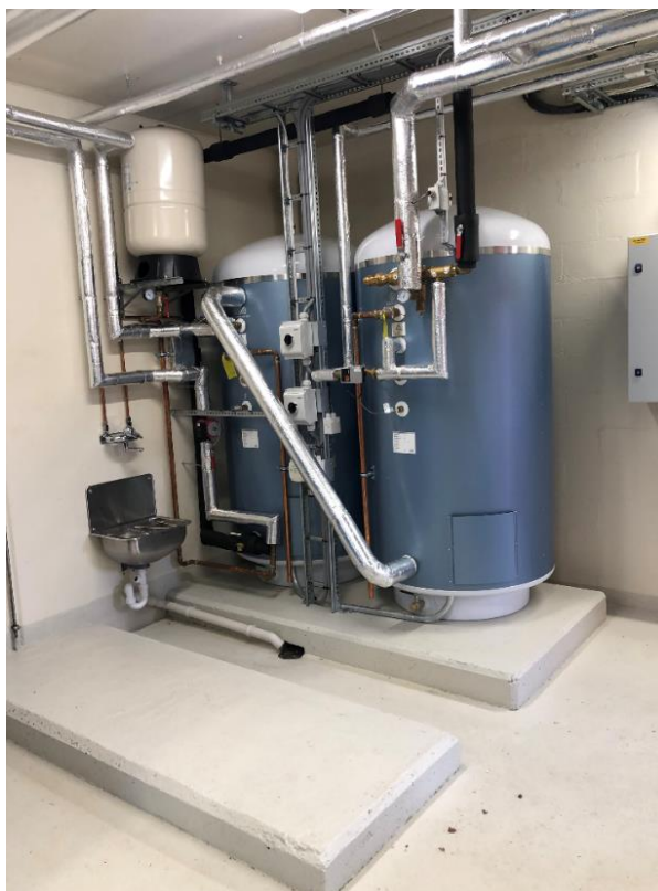
Fig.: 1 Beredere i varmesentral
