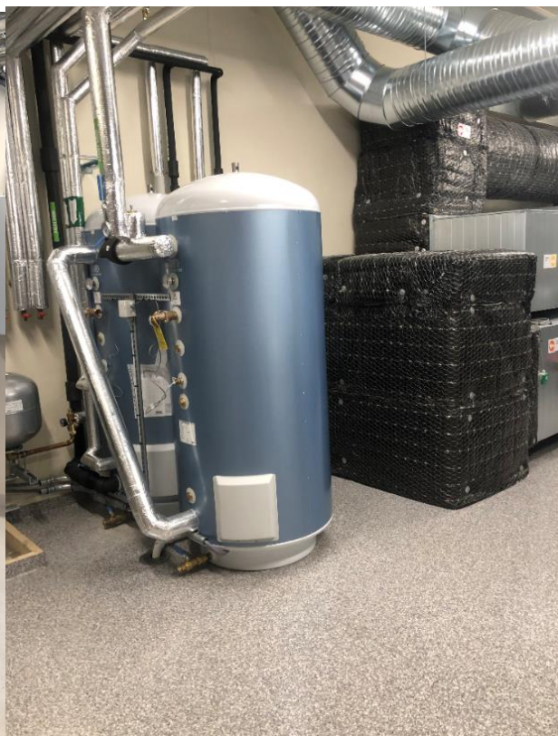
Fig.: 2 Beredere i Bygg B
