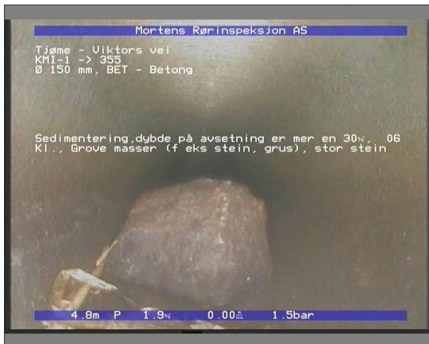
Foto: 4_1_S_Sectionname_21082019_091348_B_OV_BET_150_SM4.JPG 4,81m, Sedimentering, dybde på avsetning er mer en 30%, 06 Kl., Grove masser (f eks stein, grus), stor stein
