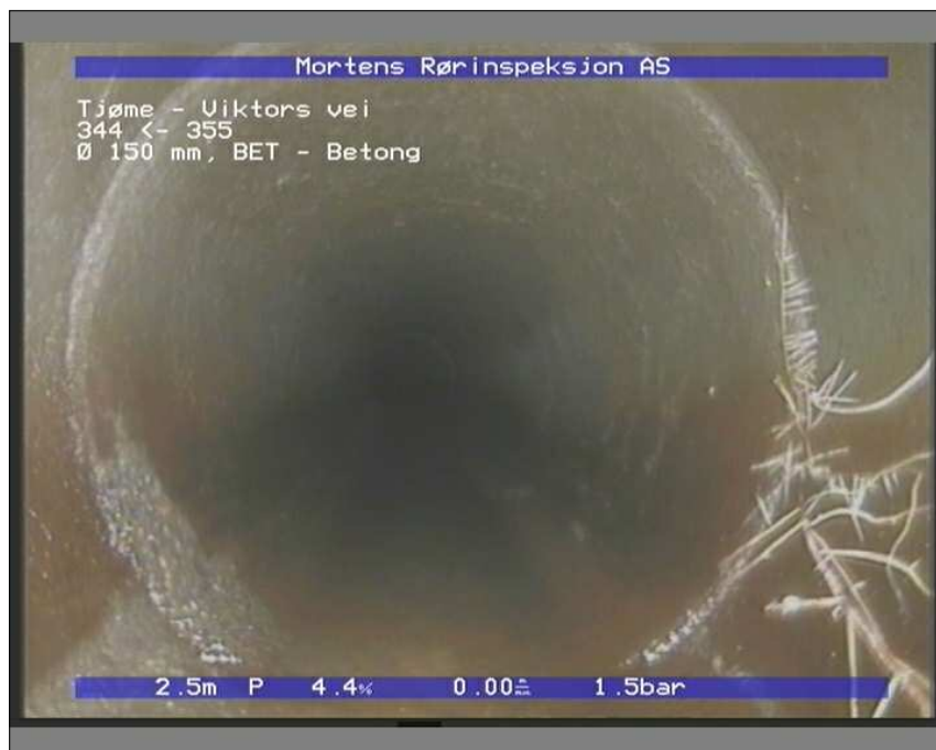
Foto: 2_1_S_Sectionname_21082019_092451_B_OV_BET_150_RØ1.JPG 1,64m, Røtter, reduksjon i tverrsnittsarealet er 5% eller mindre, fra 12 til 12 Kl., Enkelte fine rottråder, Start
