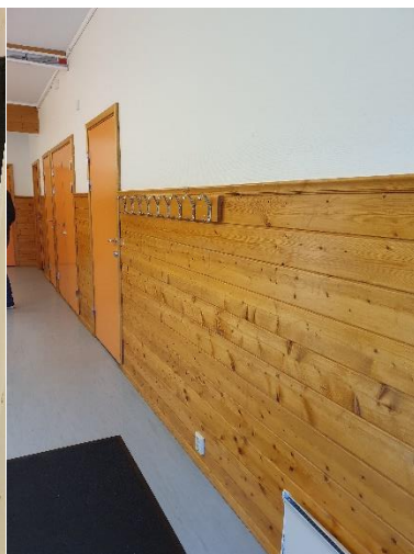
Korridor Blokk C
