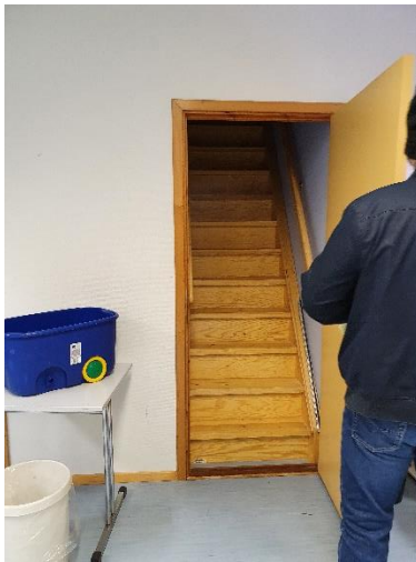
Oppgang til loft, ventilasjon.
