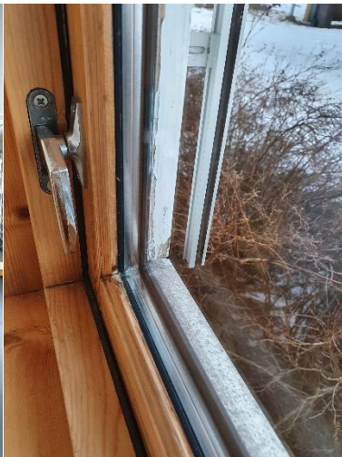
Vindu- og veggfelt fjernes, C.
