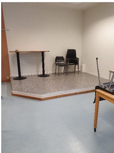
Betong-gulv skal fjernes, Blokk C.
