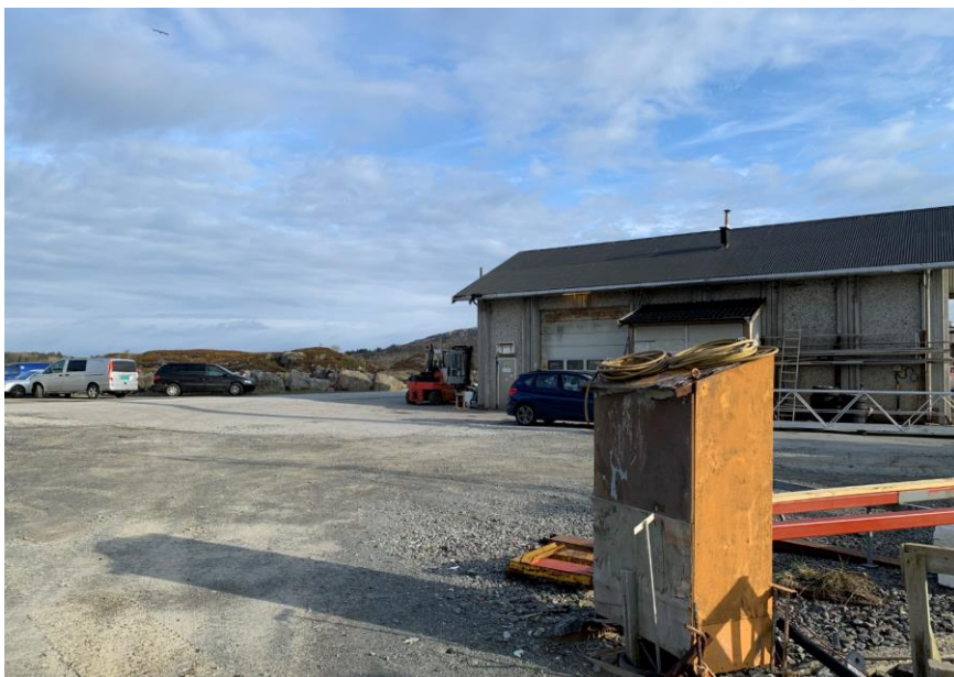
Figur 2 Bildet viser at deler av området mot nord har asfalterte flater.
