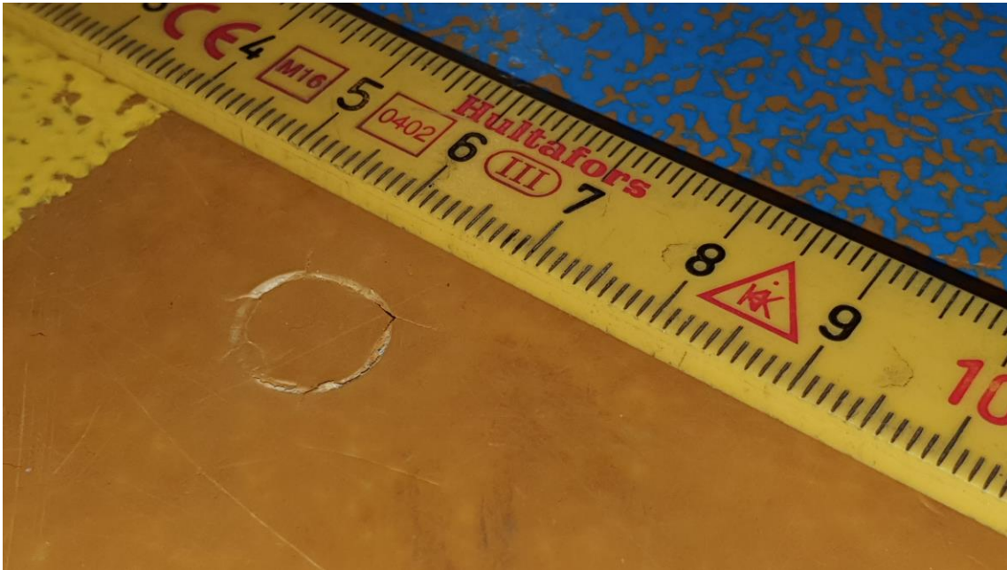
Bilde nr. 1: Full gjennomlokking av toppbelegg.
