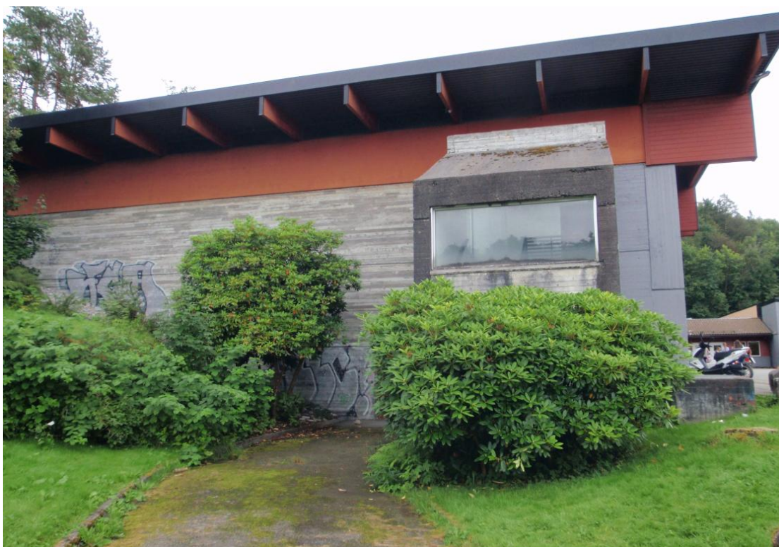
Figur 3 Eksisterende situasjon mot nord
