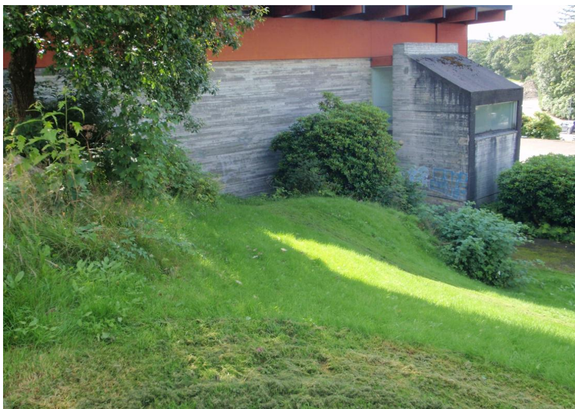
Figur 4 Eksisterende situasjon mot nord
