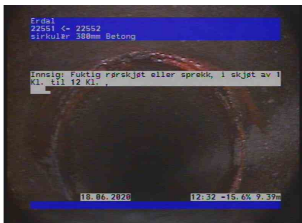
L_22551_22552__14.jpg, 00:02:00, 9.39m Innsig: Fuktig rørskjøt eller sprekk, i skjøt av 12 Kl. til 12 Kl.,
