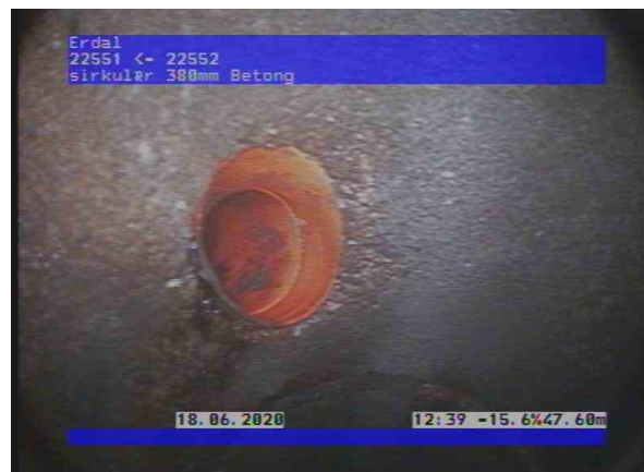
L_22551_22552__17.jpg, 00:07:10, 47.60m Tilkopling. Innhugget tilkobling på 9 Kl.
