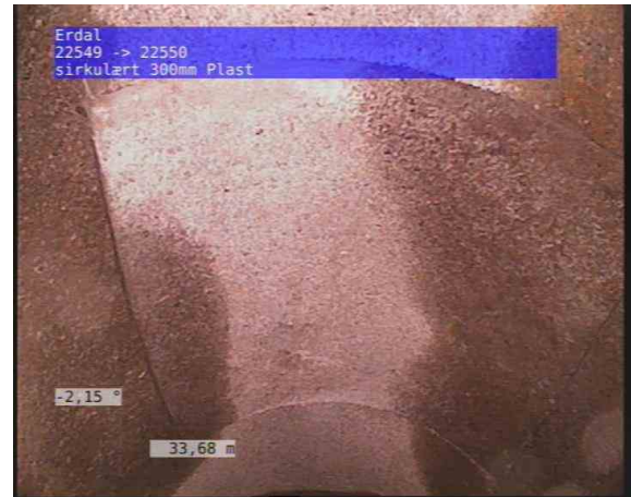
L_22549_22550_260620_091429_7.jpg, 00:06:33, 33.68m Tilkopling, Andre av 10 Kl. til 2 Kl. / luke
