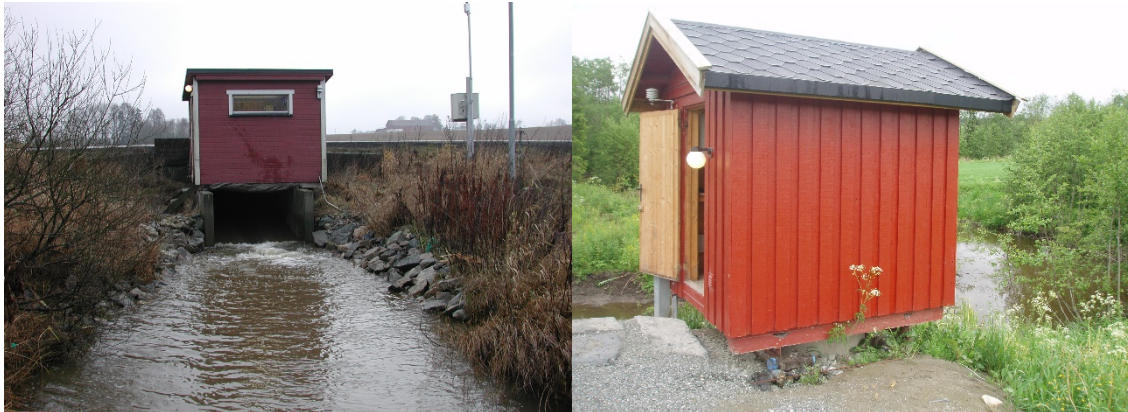
Bilde 2: To eksisterende målepunkter. Til venstre er målehytta bygget over den hydrologiske profilen, og til høyre ved siden av.
