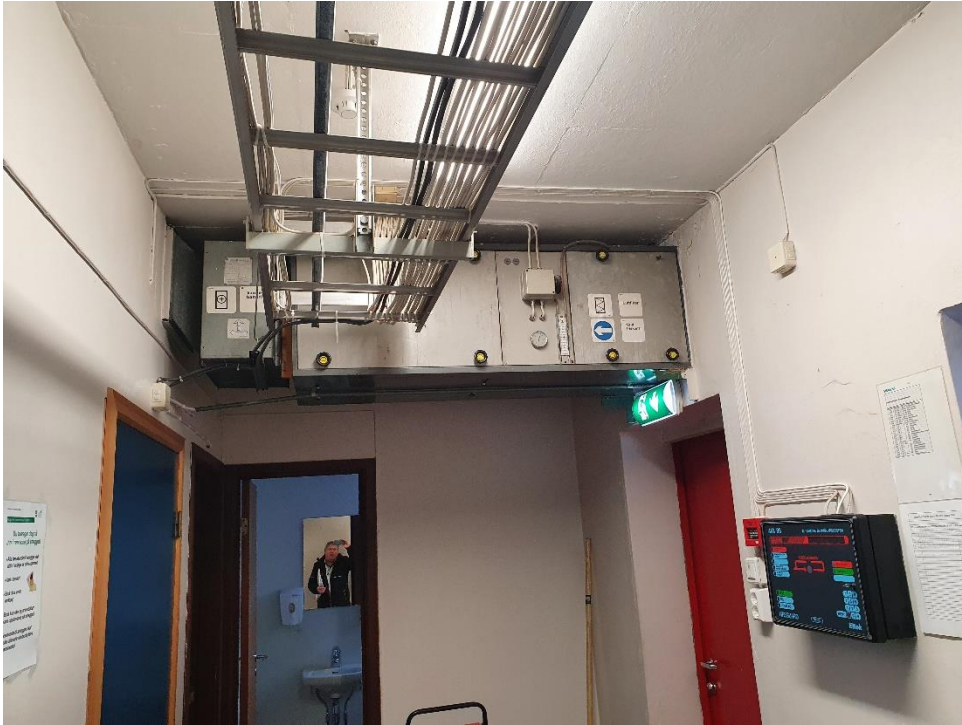
Eksisterende tilluftssaggregat 36.01
